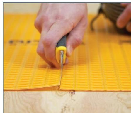
**2** Далее проводится раскрой полотна и предварительная раскладка по поверхности.
