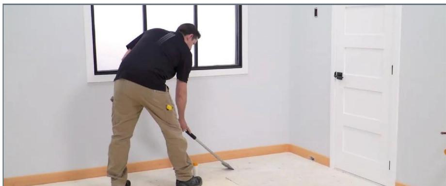
**1** Перед укладкой полотна Schluter-DITRA основание необходимо подготовить – очистить от мусора и обеспылить, закрутить торчащие саморезы, если таковые присутствуют. При наличии горизонтальных трещин шире 3,5 мм, такие трещины необходимо заделать. Чистое основание перед приклеиванием полотна увлажняют губкой, смоченной в чистой воде.
