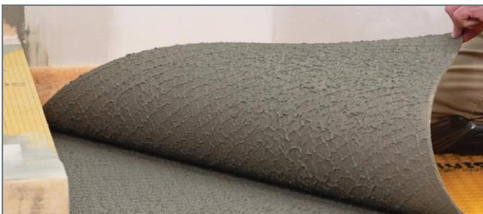
**6** Каждый приклеенный лист обязательно нужно проверять на качество приклеивания. Для этого отгибается один угол и если на основании или на изнаночной стороне полотна остались места, не покрытые клеем, то лист необходимо снять, добавить еще клея и повторить приклеивание.
