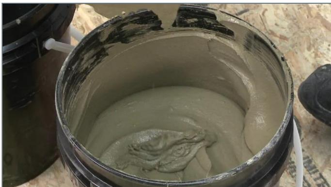
**3** Плиточный клей разводится водой на 10–15% больше, чем рекомендовано производителем (до консистенции жидкой сметаны).
