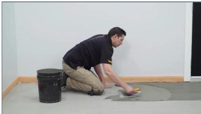
**4** Разведенный клей наносится на основание зубчатым шпателем 4 мм на площади, равной одному листу.
