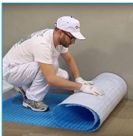
**5** Поверх раскатывается лист мембраны и прочно прижимается к полу деревянной теркой. При укладке больших площадей используется ролик нагружаемый мешками с плиточным клеем.
