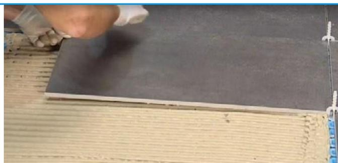
**9** Теперь можно переходить к облицовке плиточными материалами. Для этого поверх мембраны с уложенным кабелем наносится плиточный клей так, чтобы заполнились все пустоты, выполняются бороздки зубчатым шпателем и по желаемой схеме укладывается плитка либо керамогранит. Размер зубчатого шпателя и класс плиточного клея подбирается под формат укладываемой плитки.
