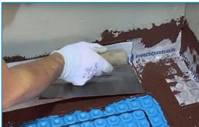
**8** Стыки листов проклеиваются гидроизоляционной лентой Proband 150 или Schluter-Kerdi-Keba 125 мм с помощью тонкого слоя плиточного клея либо гидроизоляционного состава.
