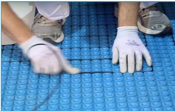
**7** Далее в желобки мембраны укладывается греющий кабель электрического теплого пола. Выводится датчик, подключается система электрических теплых полов. Шаг укладки подбирается в зависимости от используемого кабеля и необходимой мощности обогрева.
