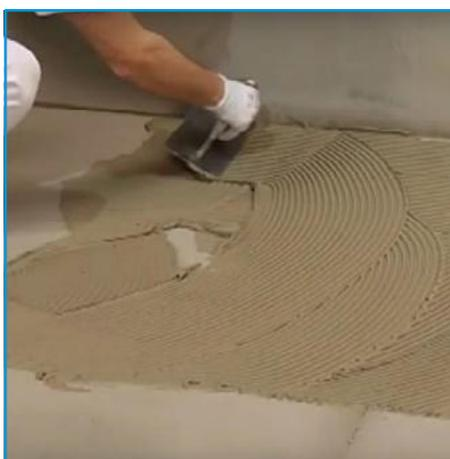
**4** Разведенный клей наносится на основание зубчатым шпателем 6 x 6 мм на площади, равной одному листу.
