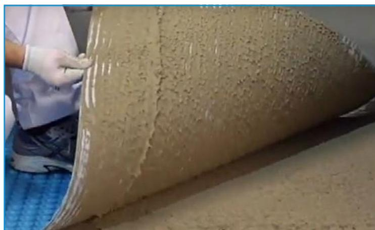
**6** Обязательно проверяется качество нанесения клея на мембрану. Для этого отгибается угол уложенной мембраны и проверяется, вся ли площадь листа покрыта клеем. Если клея недостаточно, лист необходимо снять и добавить еще слой клея на основание. Затем снова раскатать и уплотнить лист.
