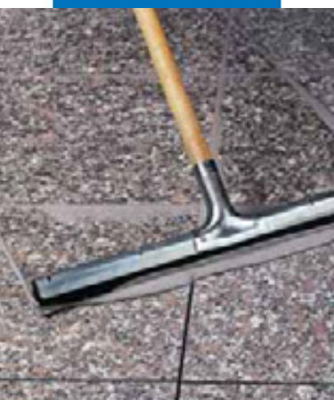
Заполнение швов в гранитных полах резиновой раклей
