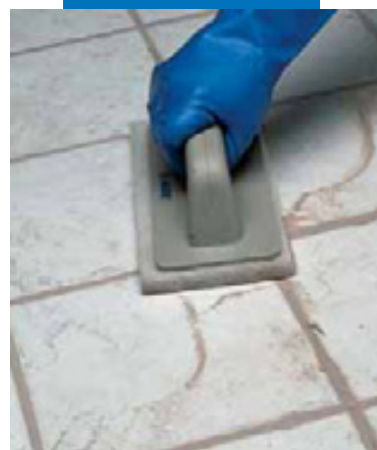
Очистка с помощью панели Scotch-Brite®
