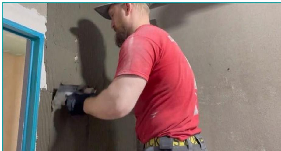
**4** Наклеивание мембраны начинается от угла. Для этого клей наносится на основание зубчатым шпателем 4 x 4 мм на площади, равной одному листу мембраны с заходом 5–7 см на примыкающую стену.
