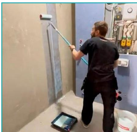
**1** Перед монтажом мембраны поверхности необходимо подготовить: очистить от грязи и пыли, выровнять поверхность (убрать бугры и наплывы растворов), закрутить до конца саморезы, чтобы ничего не торчало над поверхностью. При наличии трещин шириной более 1 мм такие трещины необходимо предварительно заделать. Минеральные (пылящие) основания необходимо загрунтовать, другие типы поверхностей достаточно увлажнить.
