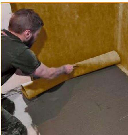
**10** На пол мембрана наклеивается по тому же принципу, что и на стены.
