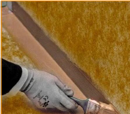
**9** После того, как все листы мембраны наклеены, следует заклеить стыки (при оклеивании встык), а также соединения «пол – стена», внутренние и наружные углы гидроизоляционной лентой Proband 150, Schluter-Kerdi-Keba 125 мм, BauLab Pro «WaterProf» или LsGuard WP200. Лента наклеивается так же, как и сама мембрана: слой клея на стык, поверх прикладывается нужный отрезок ленты и прижимается шпателем втирающими движениями.
